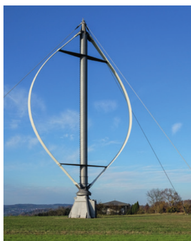
Der Darrieus-Rotor – eine Windturbine mit vertikaler Rotationsachse (© D. Krieger, CC)
